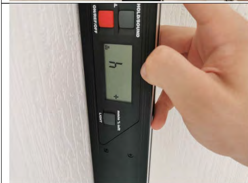
Фото №9. Измерение уровня стен в спальне.
