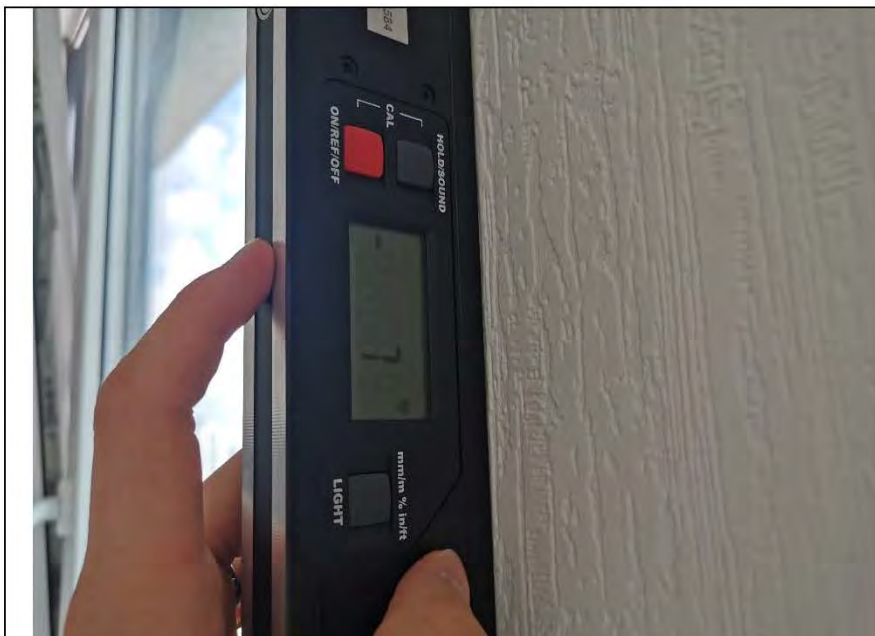
Фото №10. Измерение уровня стен в кухне.
