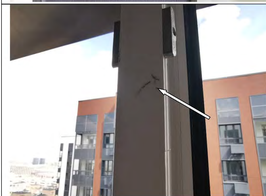
Фото №42. Загрязнение профиля ПВХ оконного блока в кухне.
