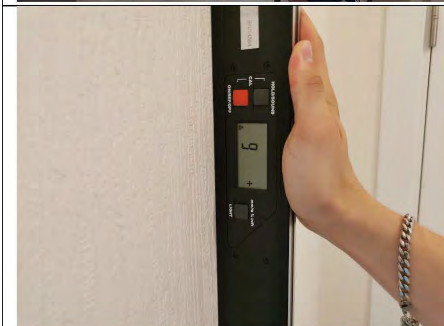
Фото №8. Измерение уровня стен в коридоре.
