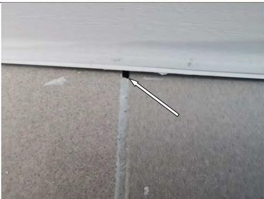
Фото №27. Неполное заполнение шовного пространства напольной керамической плитки затирочным составом в коридоре.
